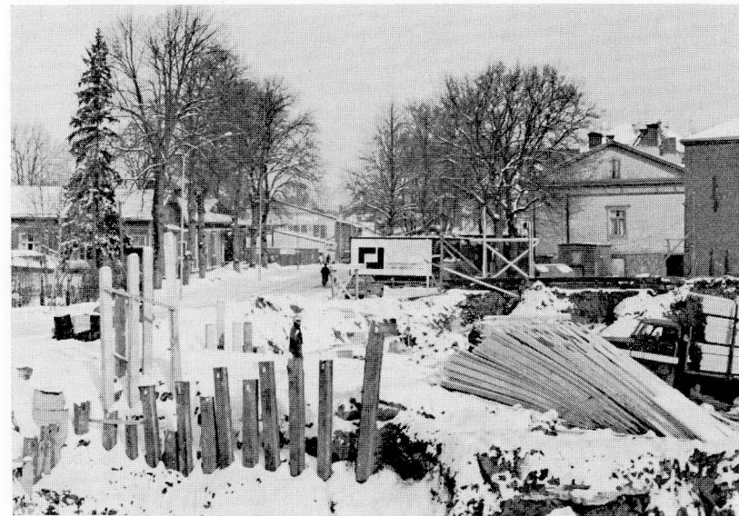
Kemisk-tekniska fakulteten får snart ett eget hus — bygget pågår.
