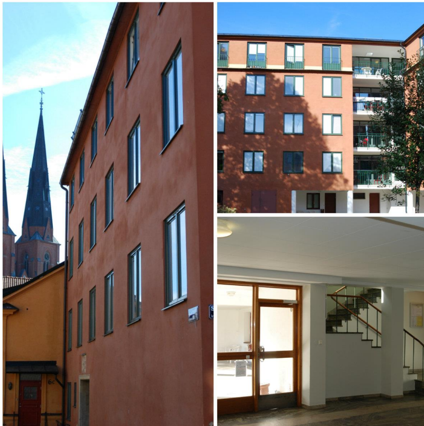
Bild 61: Södermanlands-Nerikes Arkadien (1937) i Uppsala. Fasaden ursprungligen i ljus rappning, vita balkongräcken och fönsterkarmar. Arkadien var ett av studenthemmen som fanns dokumenterade i Bryggmans arkiv och har likheter med Tavasthem i de öppna aulautrymmena, fönstren i trappan och värdringsbalkongerna. Därtill har båda tidsenliga parfönster, rappad fasad och sadeltak.
