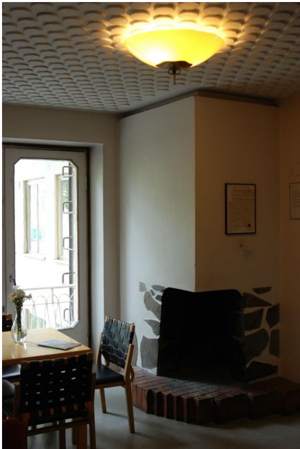
Bild 58: Den öppna brasan i den nordöstra ändan av våning tre, som fungerar som Kårkansli sedan 1992. I taket för Bryggman typiska akustiska insulitplattor och en taklampa av Paavo Tynell från Oy Taito Ab. Genom balkongfönstret syns det dekorerade balkongräcket och den för Bryggman typiska brandstegen.
