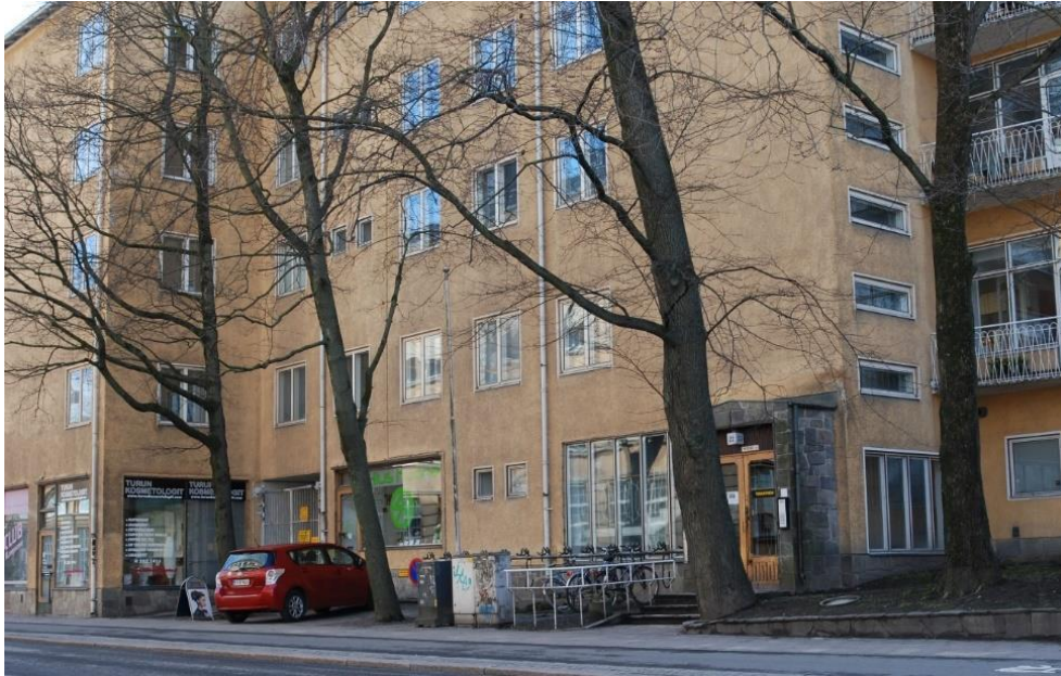
Bild 20: Studenthemmets fasad mot Tavastgatan, med affärslokaler i första våningen. Här syns också de fönster som vetter mot väst från bostadsrum och trappuppgång. Längst till höger på bilden finns den västra byggnadskroppens vädringsbalkonger mot gatan.
