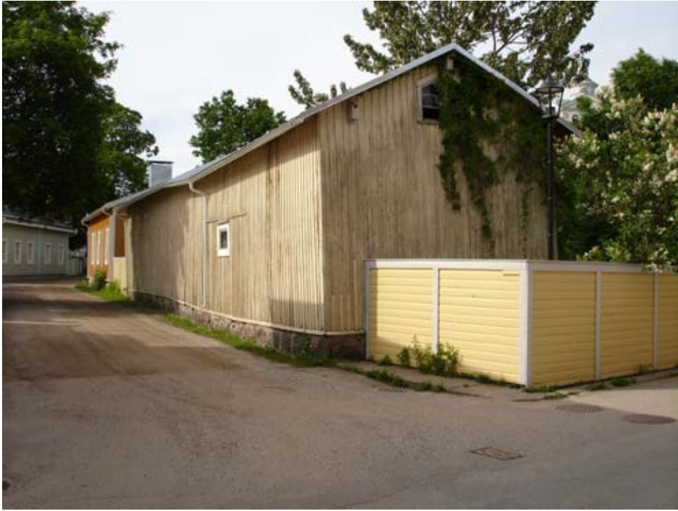
Byggnader i sämre skick hotas fortsättningsvis av rivning även om de befinner sig på det skyddade området i Gamla stan i Ekenäs. Foto: S. Lillbroända-Annala 2006. I författarens ägo.
