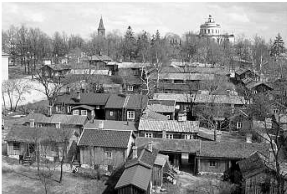
Bild 1. Hantverkarsmuseet på Klosterbacken sett från söder. De mörka husväggarna vittnar om hur brädfodringen patinerats av sol och väder när husen lämnas omålade. I förgrunden syns torvtaken på de hus som restaurerades på 1960-talet. Högst uppe på backen skymtar stentaken på gårdarna 183 och 176. En stor del av tegeltaken har lagts för att öka brandsäkerheten. Foto: ÅLM/Tom Bergroth 1973.
