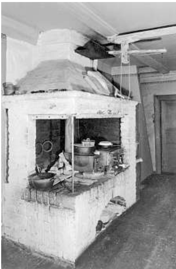
Bild 22. Interiör från ett samkök med öppen spis vid Kortelahdenkatu 22. Med hjälp av ett par miniatyrspisar ovanpå härden har köksarbetet moderniserats så att man kan använda kokkärl med flat botten. Valvet vid golvet användes som förvaringsplats för kokkärl. Foto: TMA:s bildarkiv/ E.M. Staf 1935.
