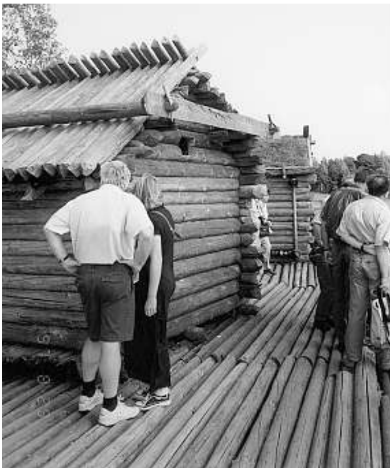
Bild 6. Arkeologisk rekonstruktion av sumpmarksbebyggelse i Āraiši, Latgallen, Lettland. Husen vilar på en stockbädd och är uppförda i knuttimringsteknik. Rekonstruktionen är utförd med stor skicklighet i knuttimring. Foto: Förf. 1997.
