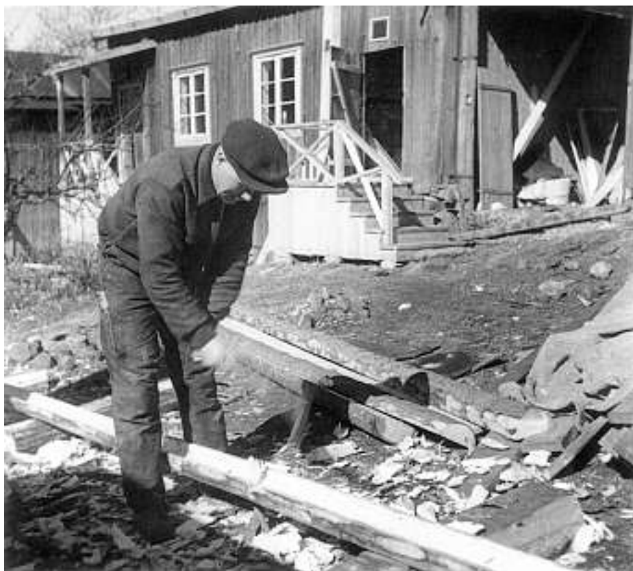
Bild 50. Då det på Klosterbacken använts takrännor av urholkat trä, tillverkades nya för museets behov. Till urholkningen används en yxa med bågformat bett, som står i vinkel mot skaftet, i motsats till en huggyxa, vars bett går parallellt med skaftet. Foto: ÅLM/Irja Sahlberg 1939.
